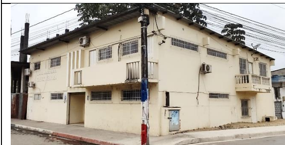
Instalaciones del GAD Parroquial Rural General Vernaza
