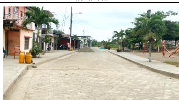
Estado de vía principal interna, Recinto Bebo
