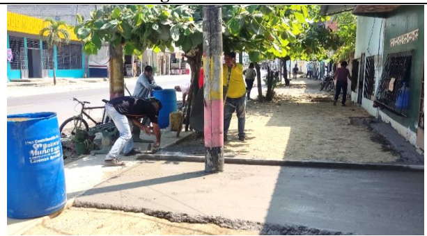
Construcción de aceras en cabecera parroquial
