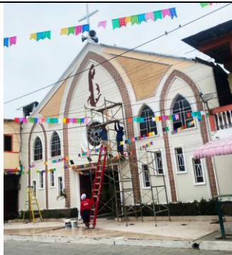
Iglesia católica central, en remodelación
